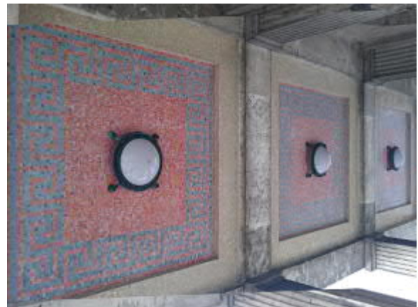
Die Deckenmosaik des „Kanzleibaus“ – hier mit den alten Deckenlampen © Rekonquista
