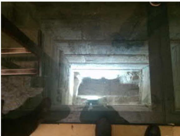
Blick auf die Basis der „Klagemauer“ – rund 8 m tiefer © Rekonquista
