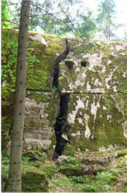
Blick auf einen gesprengten Bunker © Rekonquista
