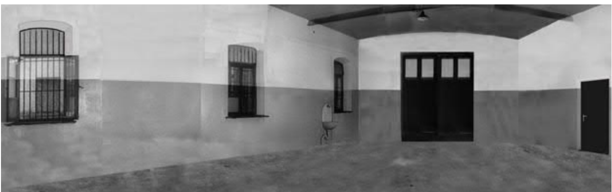
Der Blick in den Hinrichtungsraum. Stand: 27.3.1958. Die beiden Türöffnungen wurden nach 1945 zugemauert. Die beiden Fenster an der Schmalseite durch zwei Garagentorflügel ersetzt.
