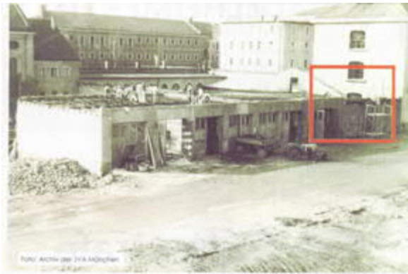
Mit der Errichtung des „Ostbaus“ im Jahre 1962 wurde die ehemalige Hinrich- tungsstätte für die Erbauung umstrukturiert.
