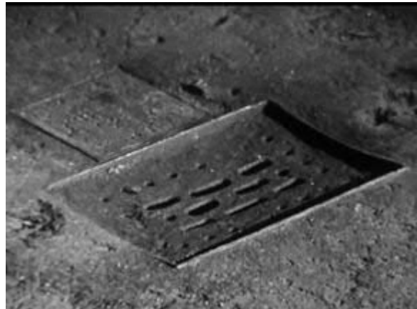
Der Abfluss für das Blut im Estrichboden im Detail © BR / Rekonquista
