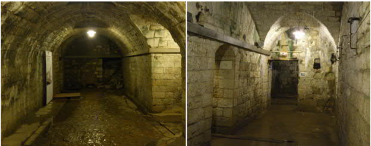
Stabil gemauerte Gänge im innern des Forts © Rekonquista
